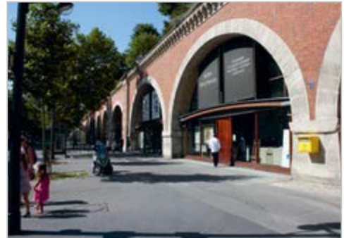
Paris, Promenade Plantée / Viaduc des Arts: linha ferroviária elevada abandonada é transformada num percurso pedestre atraente, com ateliês embaixo e um novo parque (1990)
