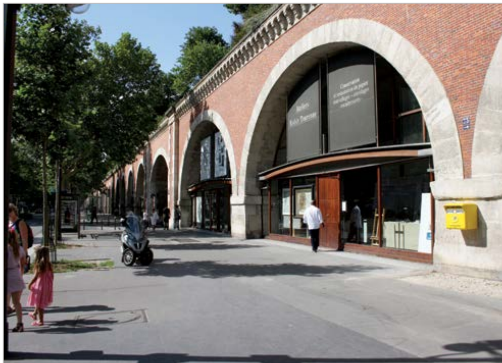
Viaduc des Arts, Paris
