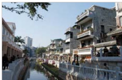
Uma rua e um canal depois da reconstrução
