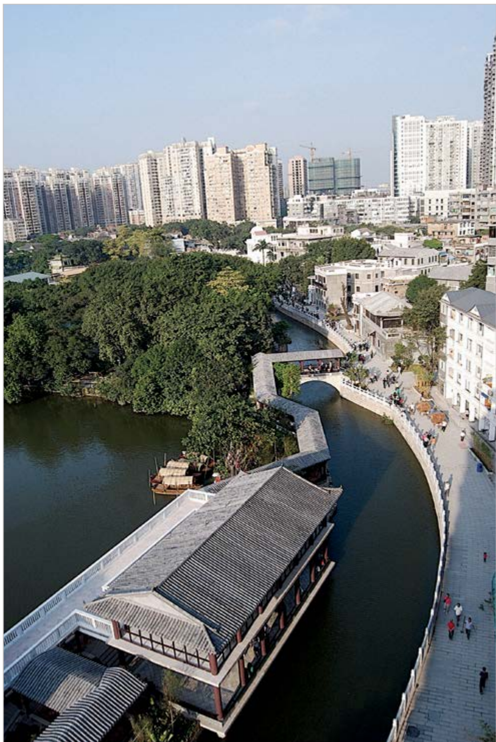
Sistema dos rios da Litchi Bay depois da reconstrução
