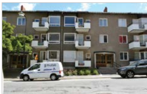
Rua do arquétipo modernista
